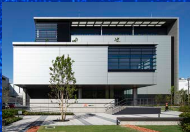
生産センター正面
